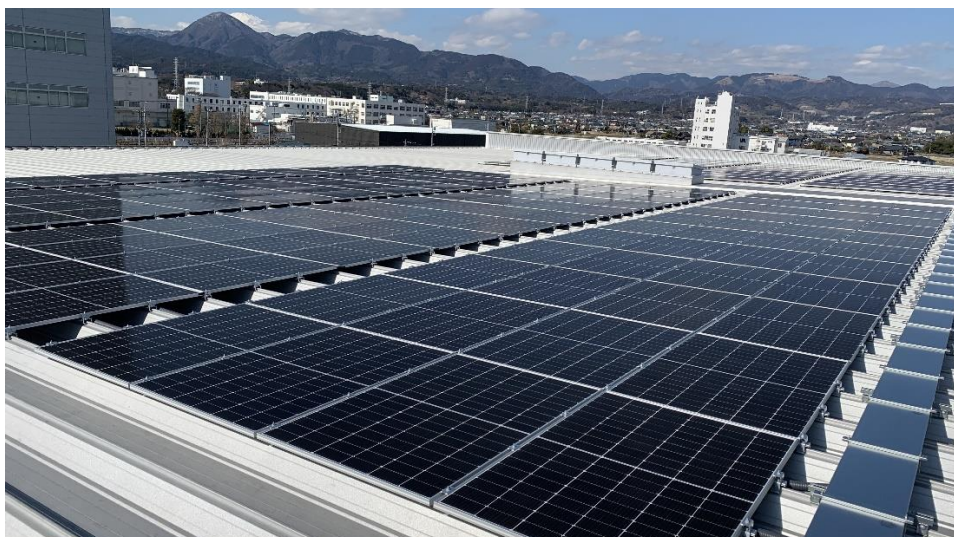
モジュールの設置状況
